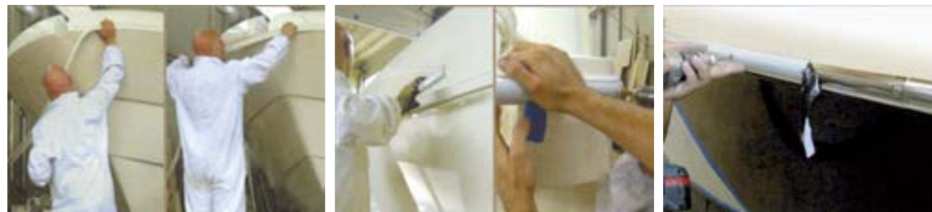
1- Instalación de la base PVC 2- Instalación de la barra de acero inoxidable 3- Instalación de los Terminales
